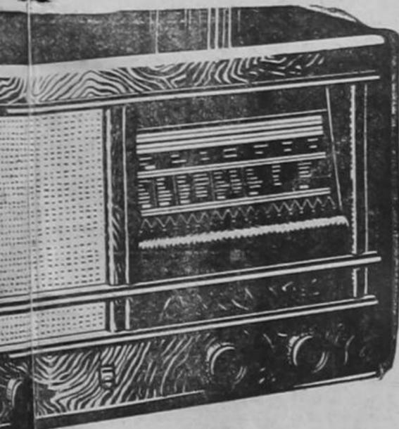
Superneterodino de 5 v. que asegura una excelente recepción en onda corta, gracias al Silentado en el caso de R.F. y al nuevo tubo triodo-hexodo como estabilizador de frecuencia. Otras características como: Compensador de sintonización termóstática, Indicador luminoso libre de paráxis, sintonización de Punto Luminoso y gama de ondas ininterrumpida de 15.5-570 m.
