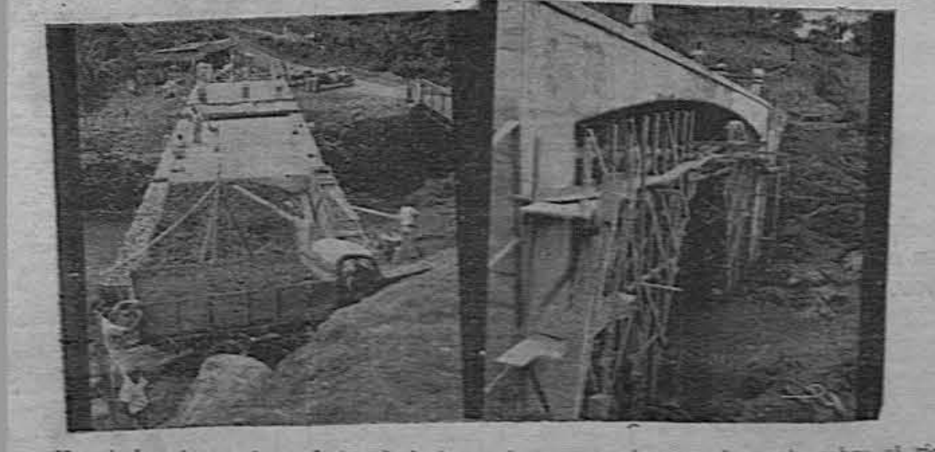
Una de las obras más perfectas de la ingeniería costarricense: el puente sobre el río Tiribi, en el límite entre Desamparados y San José. Es de cemento armado y tiene 20 metros de luz.
