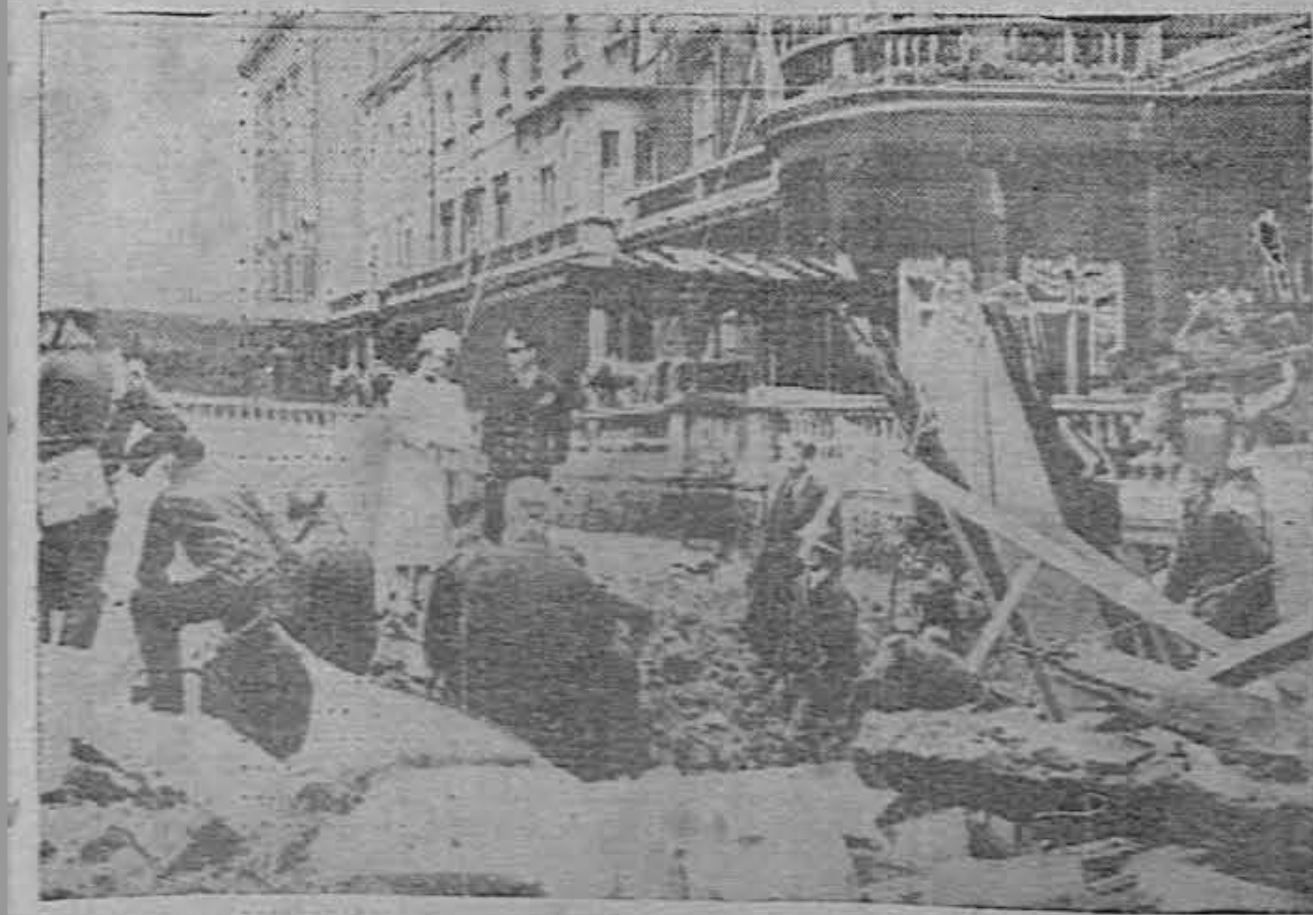
Los daños en el Palacio de Buckingham. — Los reyes inspeccionan los daños de una de las cinco bombas que cayeron en la residencia real. En este sitio había una pila de natación.
