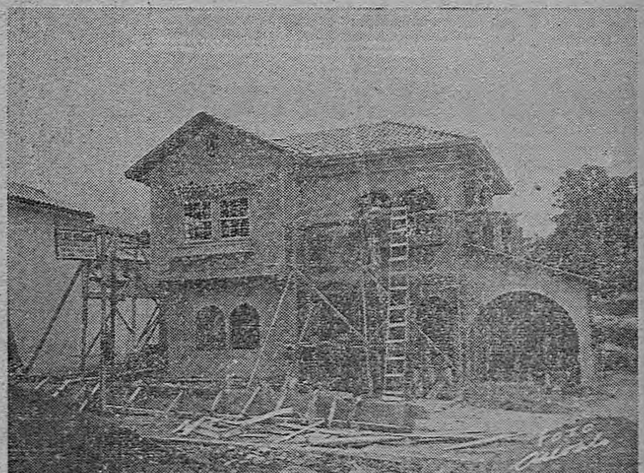
BELISIMA RESIDENCIA DOS MESES DESPUES DE INICIADA SU CONSTRUCCION: Forma parte del grupo de residencias que la Empresa Clare Hermanos llevará a cabo en la sección del Barrio González Lahmann denominada por la Empresa, El Prado. Esta y otras construcciones serán para la venta. Consulte el plan.
