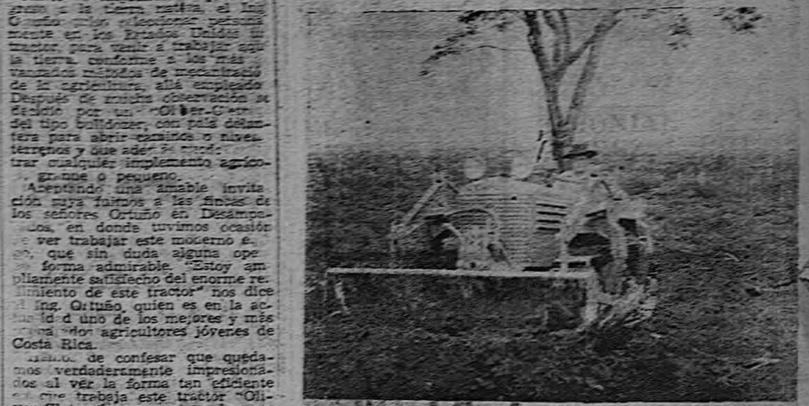
El Ing. Ortúño operando su potente tractor "Oliver-Cletrac". Puede apreciarse la magnitud del trabajo que hace la pala delantera con gran facilidad nivelando terreno o surcos caminos.
