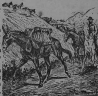
brica estas alcantarillas encajables, de tal modo, que se pueden transportar aun como balasta en los buques y son aceptados por las compañías navieras a base de peso y no de cubaje. Por tal motivo las alcantarillas van a todas partes del mundo, en camellos, en mulas, en llamas y, en muchos países, a la espalda de peones cargueros. Por lo tanto se pueden instalar en los lugares a donde no pueden llegar las de otra clase.
