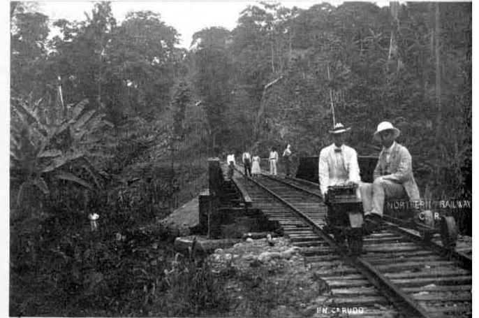
El Superintendente de Ingeniería, Sr. J. H. Burke, (al extremo derecho), acompañado por el Superintendente de Telégrafos, Sr. "Foxy Grandpa" Musgrave, cerca de Blagdon, línea de Castro. Máquinas de gasolina pequeñas fueron usadas para dar poder a carros de inspección alrededor de 1905.
