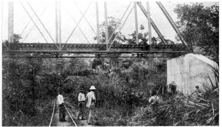
Cruce de la Northern Railway sobre la Costa Rica Railway entre el río Moín y el empalme de Moín. Los bastiones de concreto son visibles todavía, aunque el puente fué quitado cuando la Northern tomó en arriendo la propiedad de la Costa Rica Railway.
