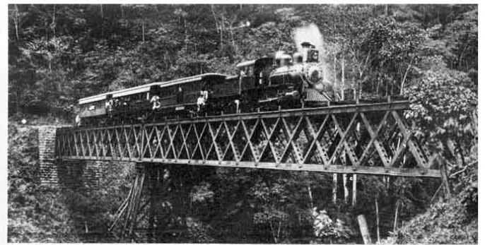
Cruzando el puente de Chiz (Milla 71.0). Note la linterna de canfín de la locomotora y el eslabón al frente de la máquina para el cabezote de enganche.
