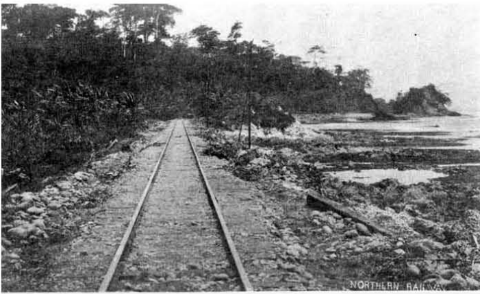
Vía de la Northern Railway entre Limón y Portete. Esta línea era superflua después de la fusión de los dos sistemas mediante un convenio de operación. La línea fué convertida en un camino público
