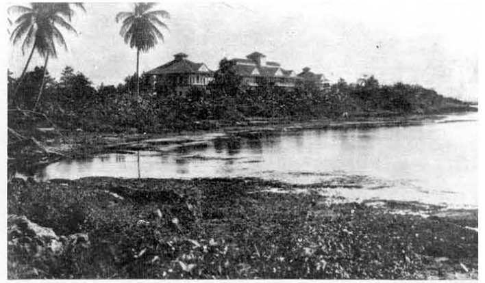
Foto de la zona del Hospital, tomada desde los talleres de la Northern Railway. El tajamar de concreto, y residencias, no existían cuando fué tomada esta fotografía en 1904.
