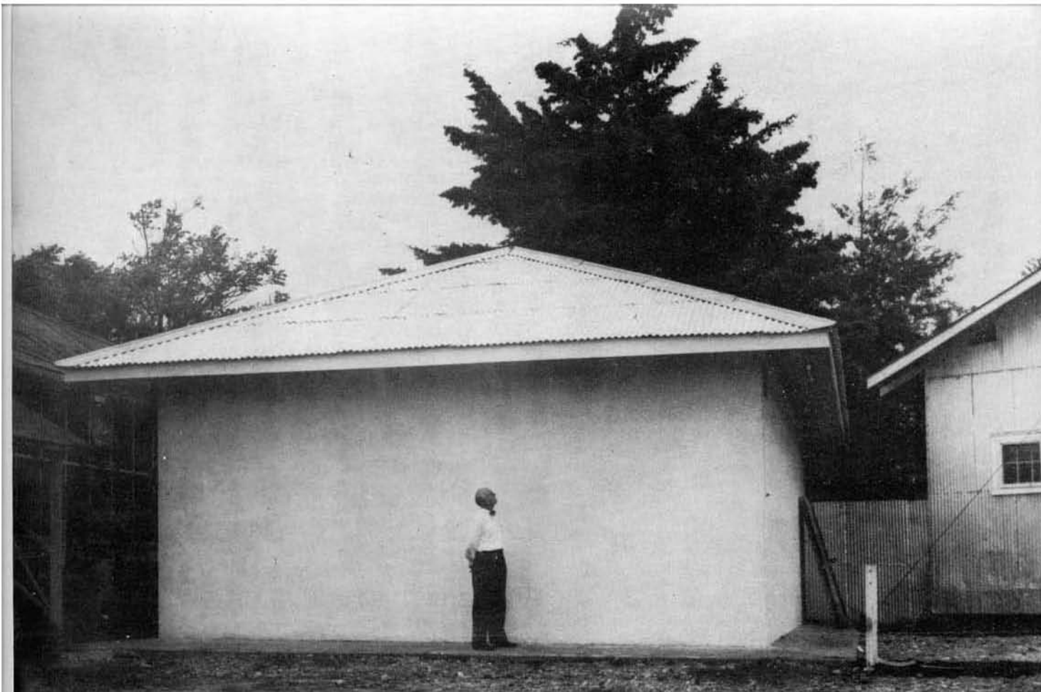
Parte exterior del edificio de archivos, San José. Esta construcción de 40 pies por 20 pies, es de ladrillo y de concreto reforzado por seis costados y es a prueba de incendios y de temblores. El edificio de la Administración está detrás de los árboles del fondo.
