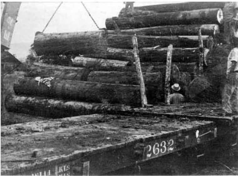
Descargando tucas para la exportación, en el patio de almacenaje en Limón. La grúa E-2 es un equipo del Ferrocarril arrendado al exportador.
