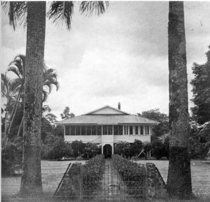
Una residencia bien atendida en Los Diamantes, Línea Vieja, cerca de Guápiles. En toda esta región, la línea del Ferrocarril es usada como "Calle Central" de manera que las residencias, y los negocios comerciales, tienen sus entradas principales al lado de la vía.
