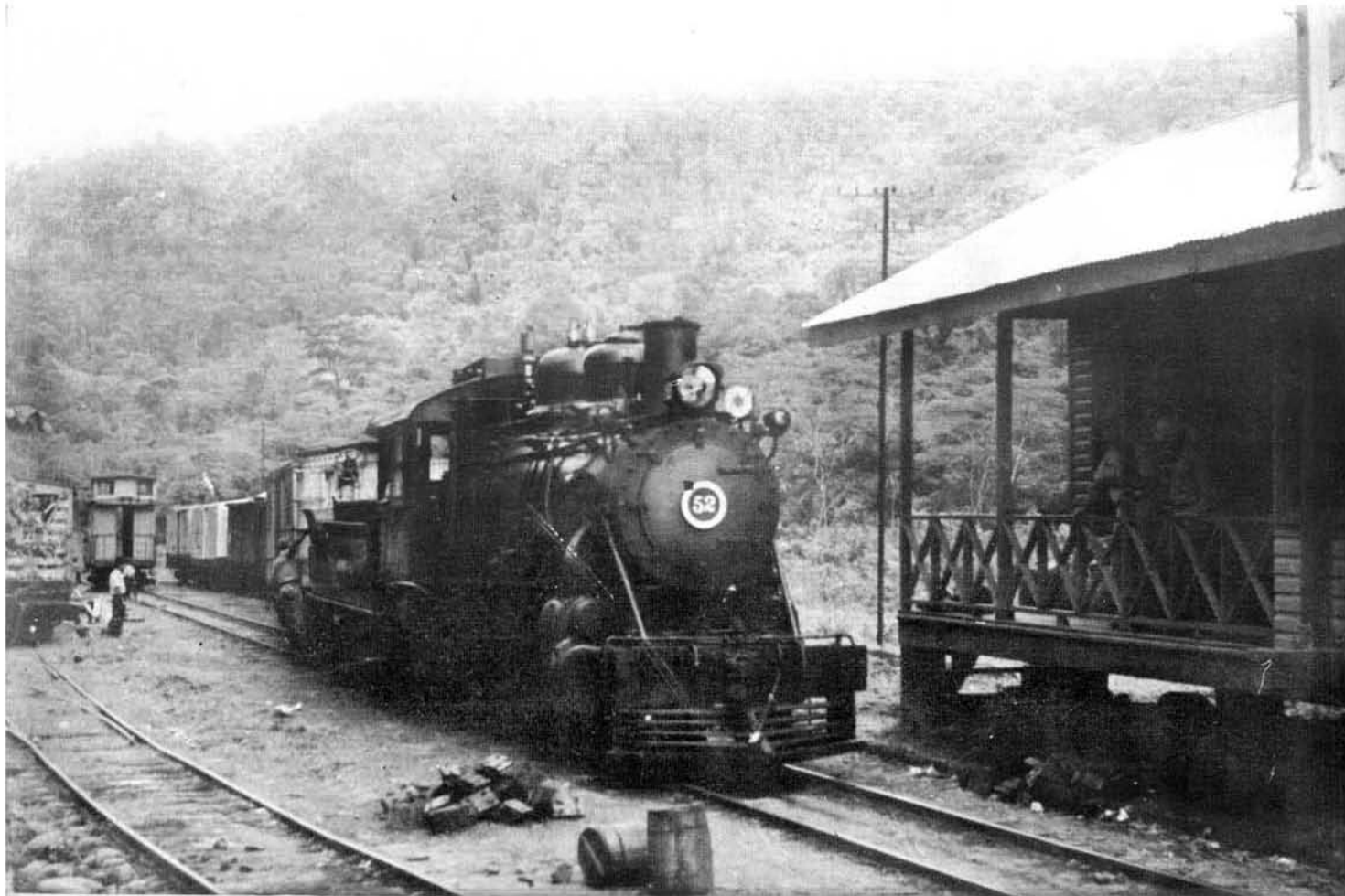
La Extra No. 52, destinada al Oeste, en la estación de Las Lomas. Las Lomas es un punto de control de tráfico. No hay población aquí excepto el campamento para la cuadrilla de sección de vías del Ferrocarril.
