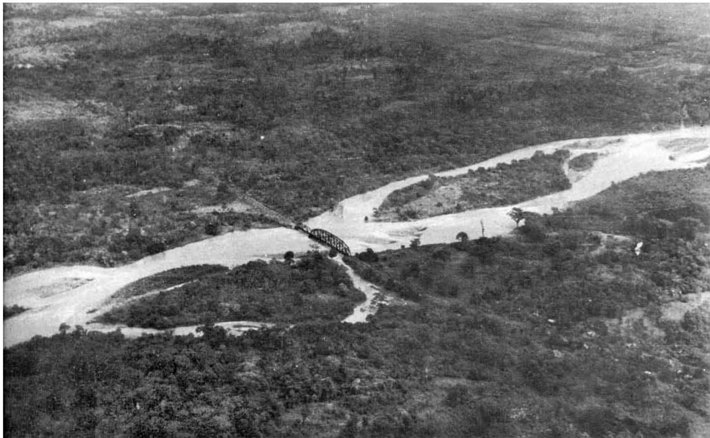
Esta es la única fotografía existente de un tramo de 160 pies construido en 1940, después que el río había desgastado la orilla (ribera) oeste abriendo un cauce nuevo el cual hizo necesaria la construcción de una apertura adicional.
