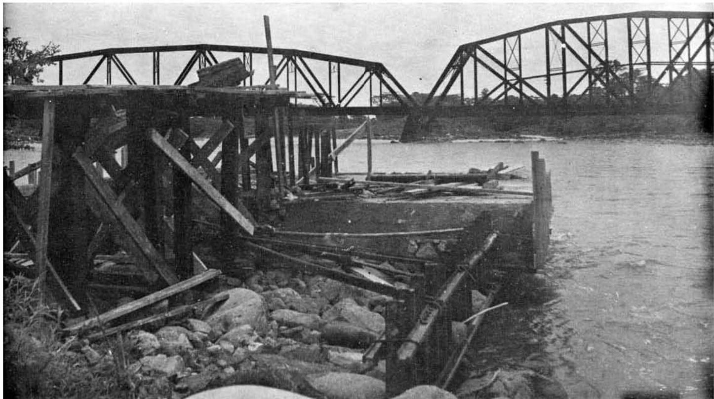
Vemos aquí un deflector bajo construcción que se colocó contra corriente en un esfuerzo para controlar la tendencia de la orilla izquierda del río de desgastarse violentamente durante las inundaciones. Nótese los rieles que se han clavado en el lecho del río y sobre los cuales se ha chorreado un bloque de concreto que formará el deflector.
