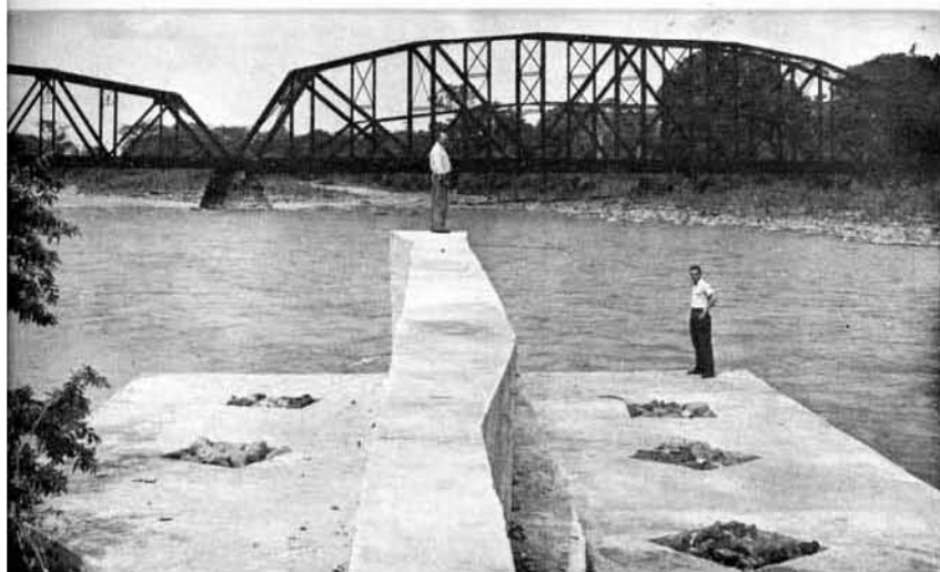
Vemos aquí un deflector bajo construcción que se colocó contra corriente en un esfuerzo para controlar la tendencia de la orilla izquierda del río de desgastarse violentamente durante las inundaciones. Nótese los rieles que se han clavado en el lecho del río y sobre los cuales se ha chorreado un bloque de concreto que formará el deflector.
