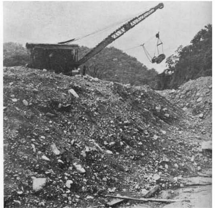
Una draga de arrastre con motor Diesel en su trabajo.
