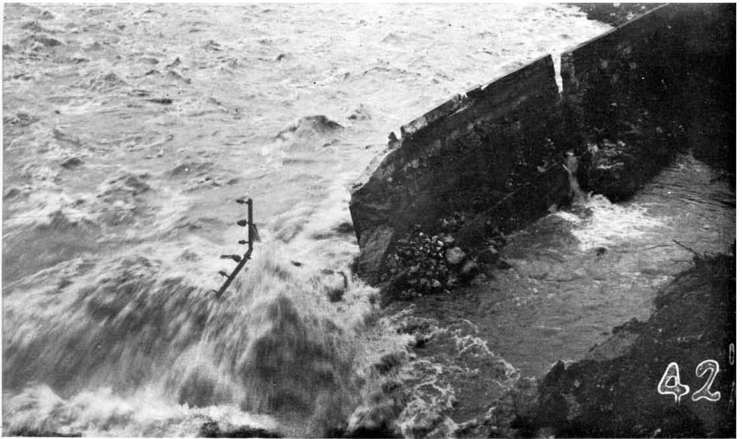
Una pared de retención en la Milla 42½, hecha en 1935, falló en Diciembre 1949. La sección inclinada cayó pocos días después de haber tomado esta fotografía.
