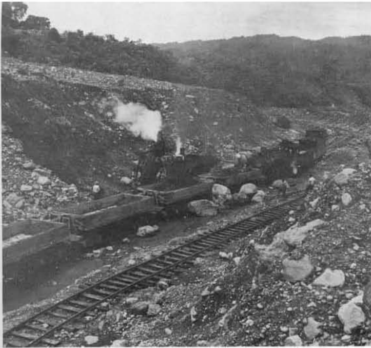
Una pala de vapor carga carros de volteo para hacer un corte de 40 pies a través de un derrumbe.
