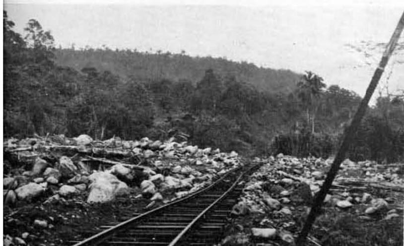
La línea temporal fué extendida sobre las rocas con solamente un corte poco profundo en el punto más alto. Esto resultó en una gradiente de cuatro por ciento en el lado Este. Más adelante la vía fué restaurada al nivel original y a una gradiente de dos por ciento.
