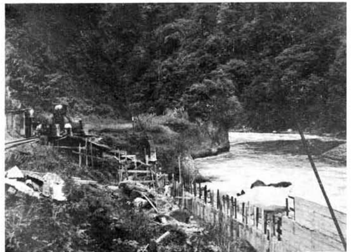
Vista de cerca del trabajo. Esta pared es una sección de gravedad chorreada en tres tapas. Aquí las formaletas están puestas para la segunda tapa. Esta es una pared pequeña pero costó $ 10,014.00 (₡ 56,779.00).
