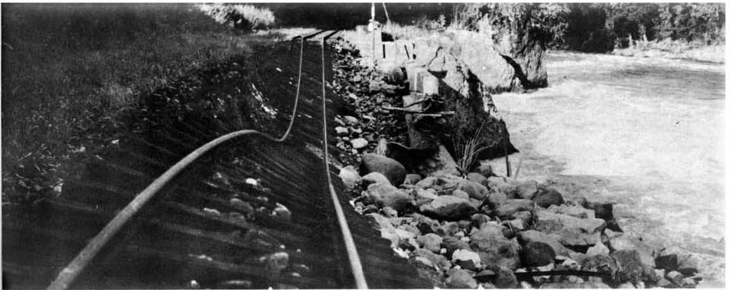
Vista de cerca de la línea colgando en el aire en Milla 50¼. Esta es la misma línea vista en la fotografía aérea.
