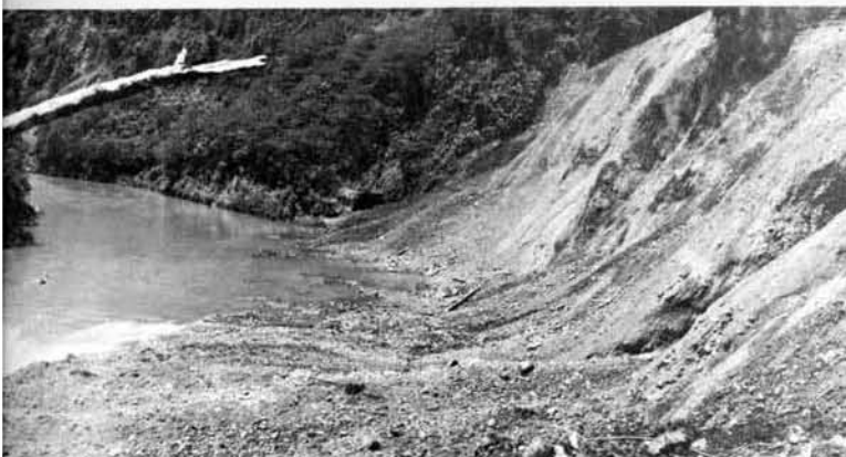
Foto (tomada antes del derrumbe) muestra la entrada al túnel ya obstruída. Cuando el río estaba bloqueado, el agua se levantó hasta más arriba de la cima del túnel. Cuando el río se abrió paso por el bosque, el agua pronto bajó hasta el nivel que la fotografía muestra.
