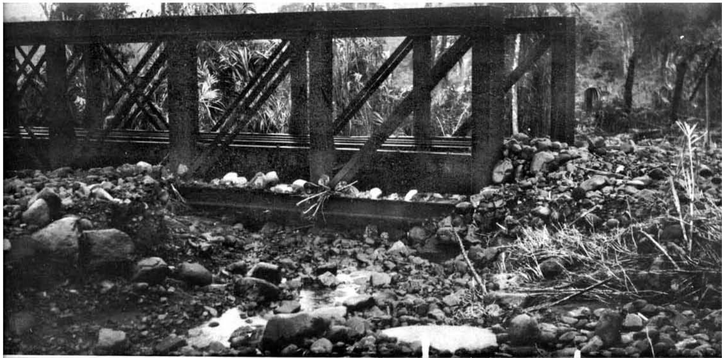
Un arroyo, normalmente pequeño, en la Milla 57 1/2, llamado Las Lajas, pasaba debajo de este puente. La inundación de Diciembre 1949 primero bloqueó el puente y después cambió el curso media milla arriba y cruzó la vía un cuarto de milla al Este del puente. Más tarde el puente fué levantado y el río restablecido en su cauce original.
