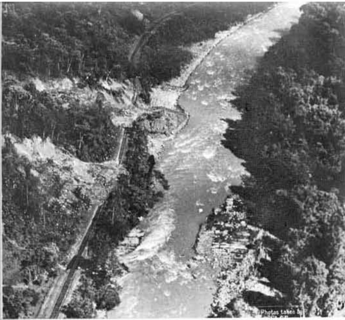
Vista aérea del derrumbe de 1949 en la Milla 47 y 47¼. Este fué solamente una parte del gran movimiento (de 1951) que también incluyó el movimiento en la Milla 48½, pero que en un principio no fué reconocido como tal.
