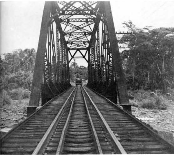
Este puente de armadura de 162 pies a través del río Madre de Dios ha sido fotografiado porque es típico.
