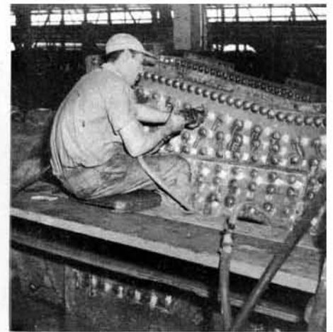
Para facilitar el trabajo de tirantes, esta caldera se ha puesto sobre su dorso.
