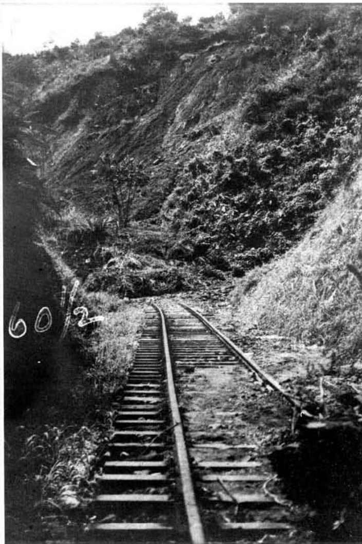
Los derrumbes grandes son casi imposibles de retratar si no es desde el aire. Esta es la mejor fotografía que se pudo hacer desde la tierra. Compárela con la fotografía aérea de la página anterior.
