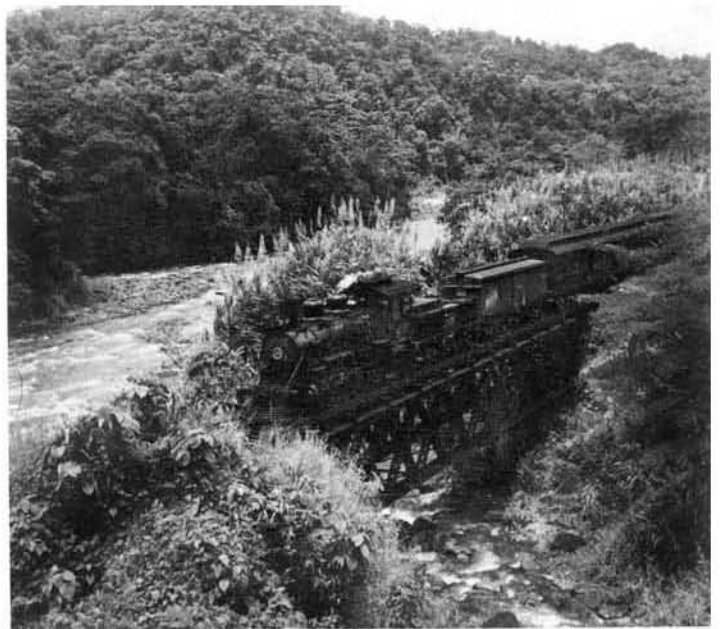
Este puente de tablero superior (deck truss) en Torito (Milla 57 ¼) es típico de muchas estructuras similares.
