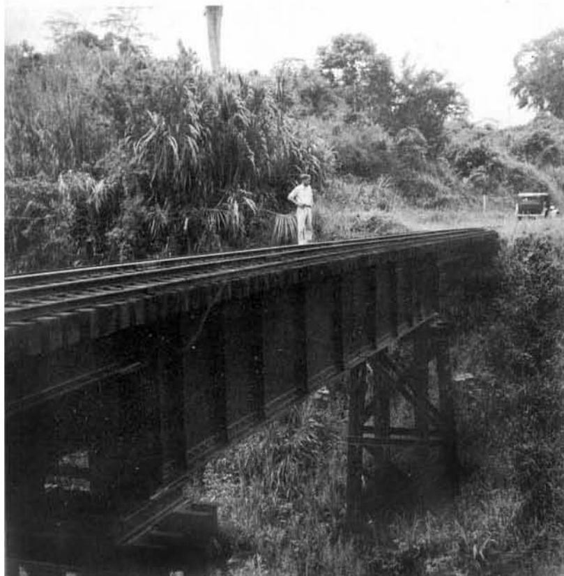
El puente de caballetes temporal fué reemplazado con este tramo que consiste de un puente de acero de 60 pies, y dos tramos de acceso de vigas de acero de 30 pies, todo construido encima de pilotes de acero de 8" x 10". El costo de este puente permanente fué de $ 17,423.00 (¢ 98,788.00).
