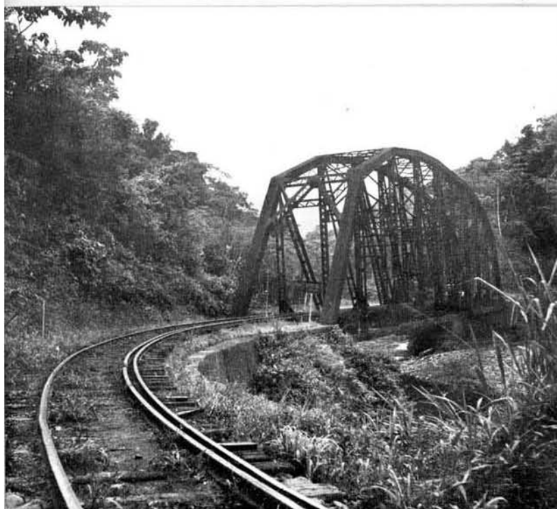
El puente más largo es el cruce del río Matina. Esta vista muestra dos tramos centrales y apenas es visible uno de los tramos de acceso. El puente consiste de cuatro tramos de armadura de tablero inferior y nueve tramos de vigas compuestas o de paso superior. La longitud total es de 1321 pies.
