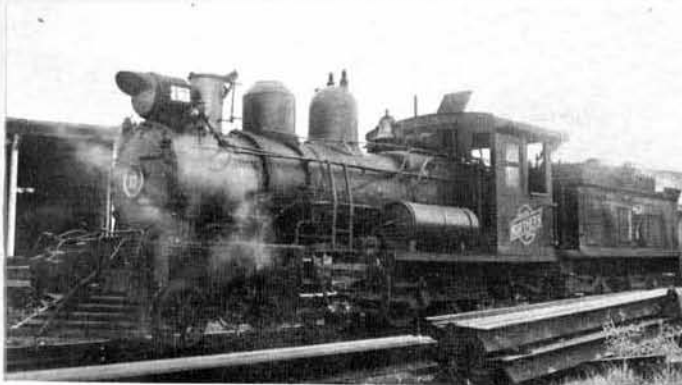
Locomotora No. 17. Una de las cuatro (15 - 18) de este tipo que están en servicio. Construída en 1899 - 1900 por Nasymth Wilson Co., Inglaterra; pesa 132,000 libras y tiene 48 pies de largo. Esfuerzo de tracción: 16,800 libras. Servicio mediano.
