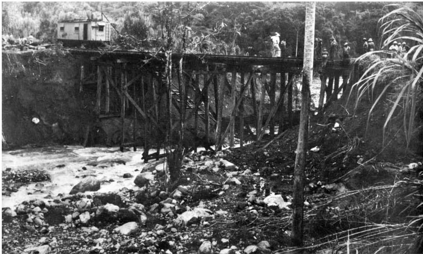
Aquí se ve el puente de caballetes temporal en Guayabo, ya terminado. El costo total fué de $ 6,090.00 (¢ 34,530.00).
