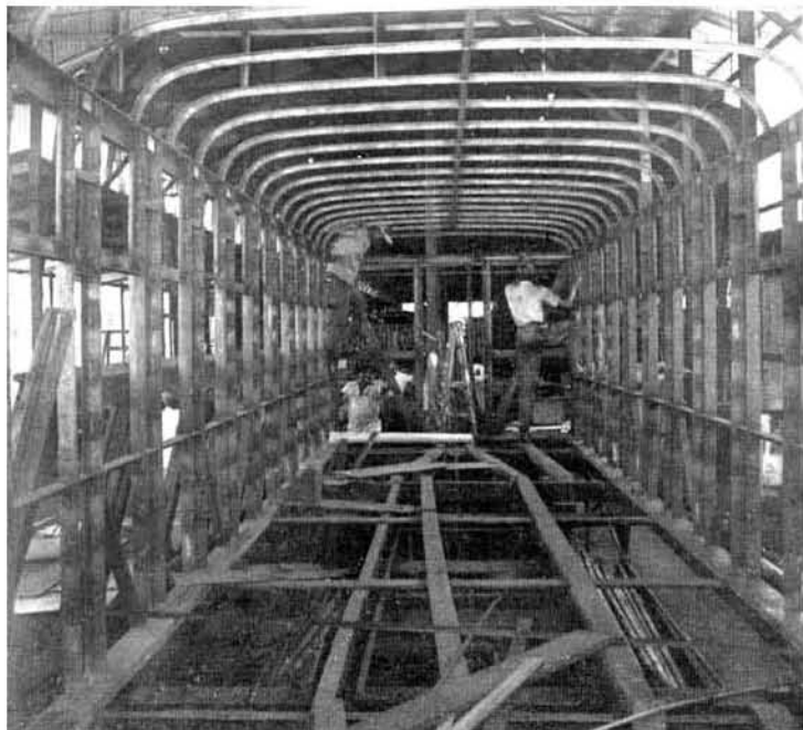
Dos vistas de un coche de pasajeros, de acero, en construcción. Para reforzar el armazón todos los puntos de encuentro se juntan por soldadura eléctrica. La parte interior del coche será forrado con tablas de material "masonite".
