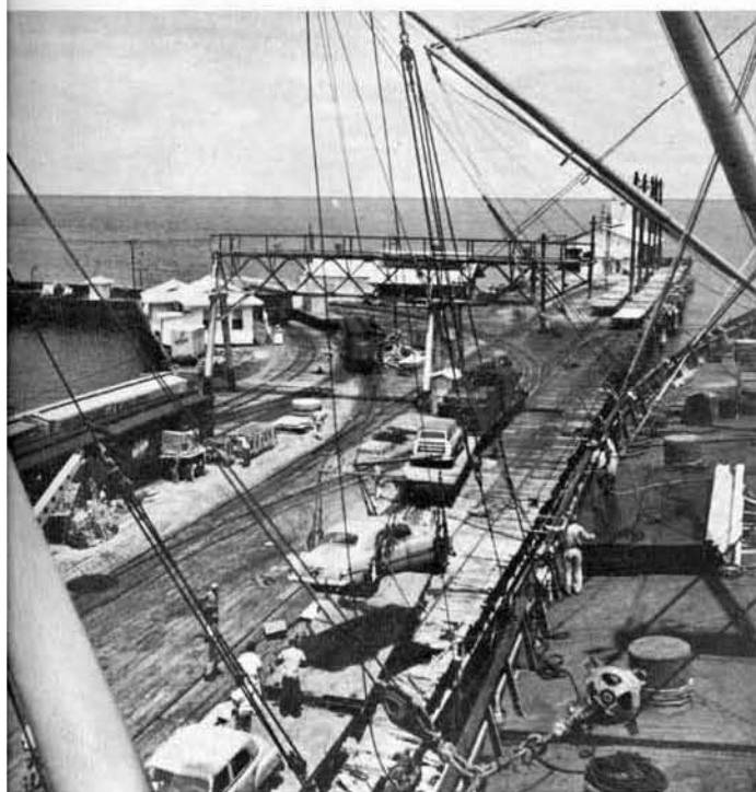
Aquí el automóvil está "al costado", y es puesto en posición sobre el carro-plano. Nótese la "grúa móvil", con linga de carga, en la parte inferior izquierda de la fotografía.
