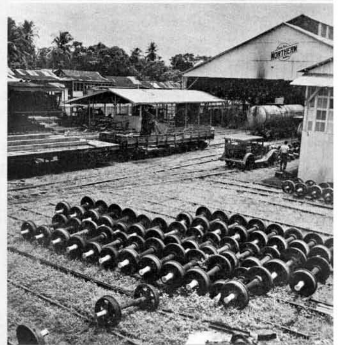
Depósito de ruedas gastadas y corregidas en el torno para ruedas, que se reservan para usarse al necesitar un cambio rápido. Durante el año fiscal 1952-1953 se cambiaron 323 pares de ruedas y se renovaron 90 ruedas. Una rueda de 28" cuesta aproximadamente $ 80.00 y una de 24" aproximadamente $ 73.00.
