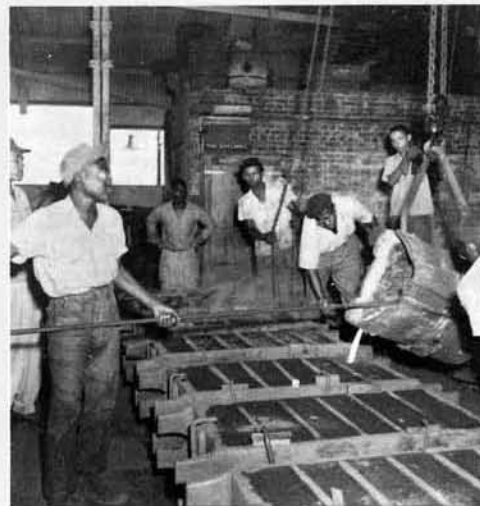
Vaciando hierro fundido en los moldes. También se hace fundición de bronce. La estructura de ladrillo que se ve al fondo es el horno para machos de arena.
