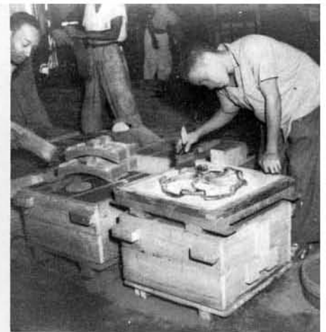
Moldes de arena para zapatas de carro y para rueda del breque de mano.
