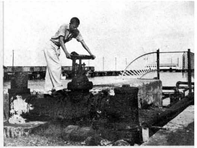
Los tanques de aceite conectan directamente con los barcos-tanque por medio de este tubo de 12 pulgadas. Un barco tanque trae generalmente de 40 a 50 mil barriles cada viaje.
