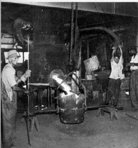
Hierro fundido vaciándose de la cúpula al caldero. El hombre con los brazos en alto controla la grúa eléctrica que mueve el caldero en posición para vaciar el metal fundido a los moldes.
