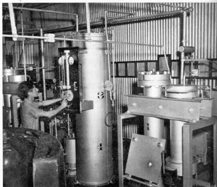
Planta de oxígeno. Durante el año fiscal 1952-1953 esta planta, valorada en $ 15,000.00 produjo 1,164 cilindros de oxígeno de 1,800 lbs. de presión cada uno. Esto fué suficiente para cubrir las necesidades del Ferrocarril y también para suplir al Hospital de Limón y a algunos particulares.
