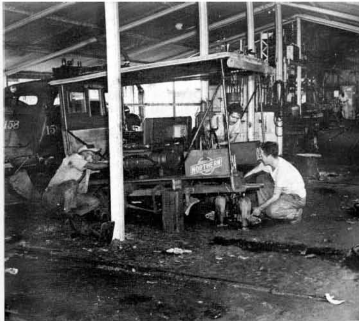
Carro motor pequeño de inspección, en reparación. El ferrocarril tiene en uso un total de 31 carros motor.
