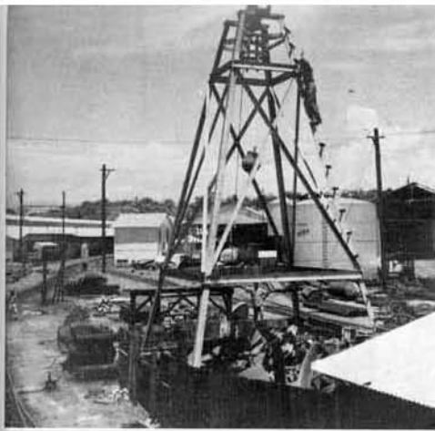
Piezas viejas de hierro fundido para ser usadas en la fundición. La bola que se ve cayendo pesa 800 libras.
