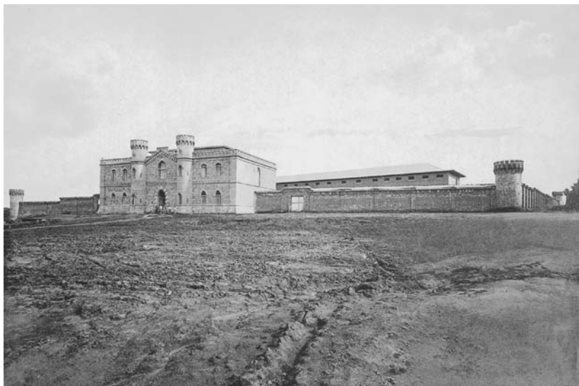
La Penitenciaría en construcción. 1909.
