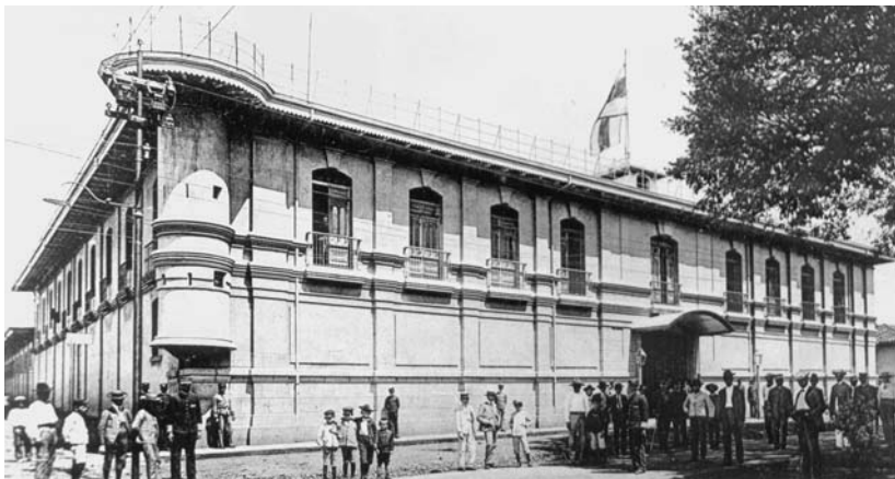
Cuartel de Alajuela. 1909 (la nueva casa de la imprenta de los Sibaja en el siglo XXI).
