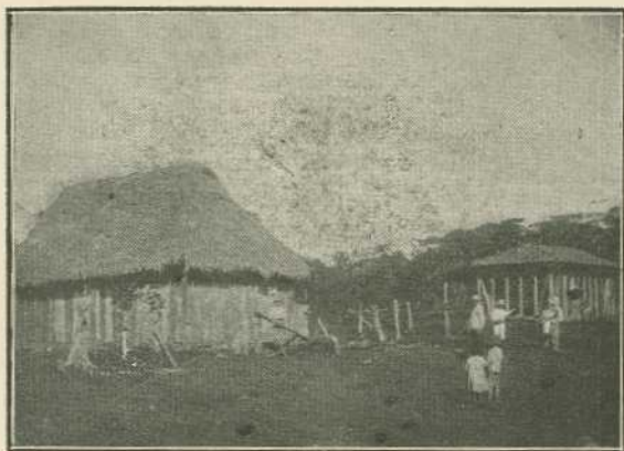
Iglesia de techo pajizo y escuela en construcción en "El General"
