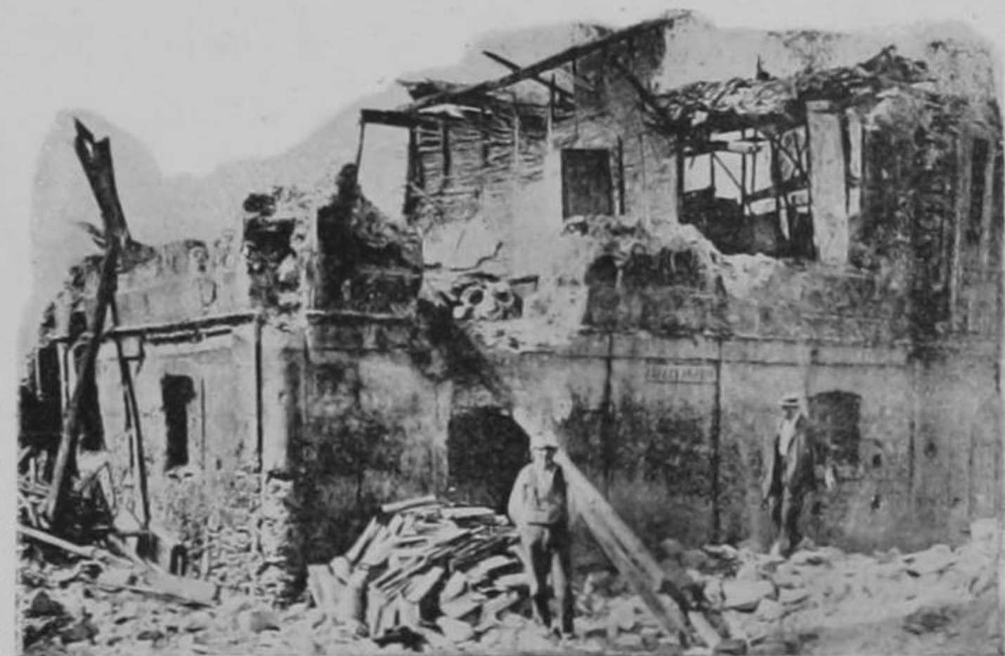
Casas de la Calabria destruidas en el terremoto de 1905
