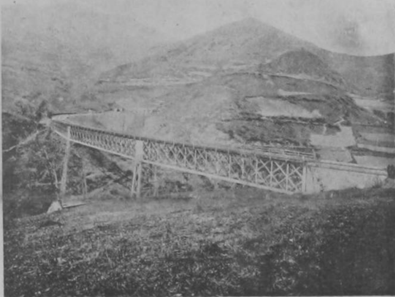
Puente curvo del Puerto de Pajares
