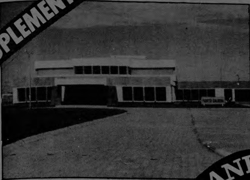
En esta gráfica fachada del edificio del INCOP en el puerto de Caldera, cuando estaba recién construido.
