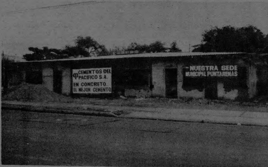
Vista parcial de la nueva SEDE DEL MUNICIPAL PUNTARENAS F.C. la cual se construye gracias al aporte de varias empresas incluyendo a CEMENTOS DEL PACIFICO S.A.
