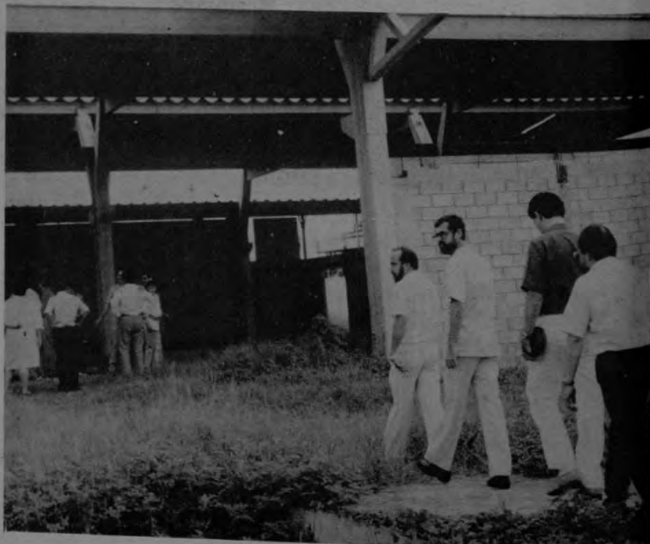
Vista parcial de lo que ahora son las ruinas de las instalaciones de Zona Franca. Se espera que con la reciente firma del Convenio INCOP-ZONA FRANCA se continúe con la infraestructura.
