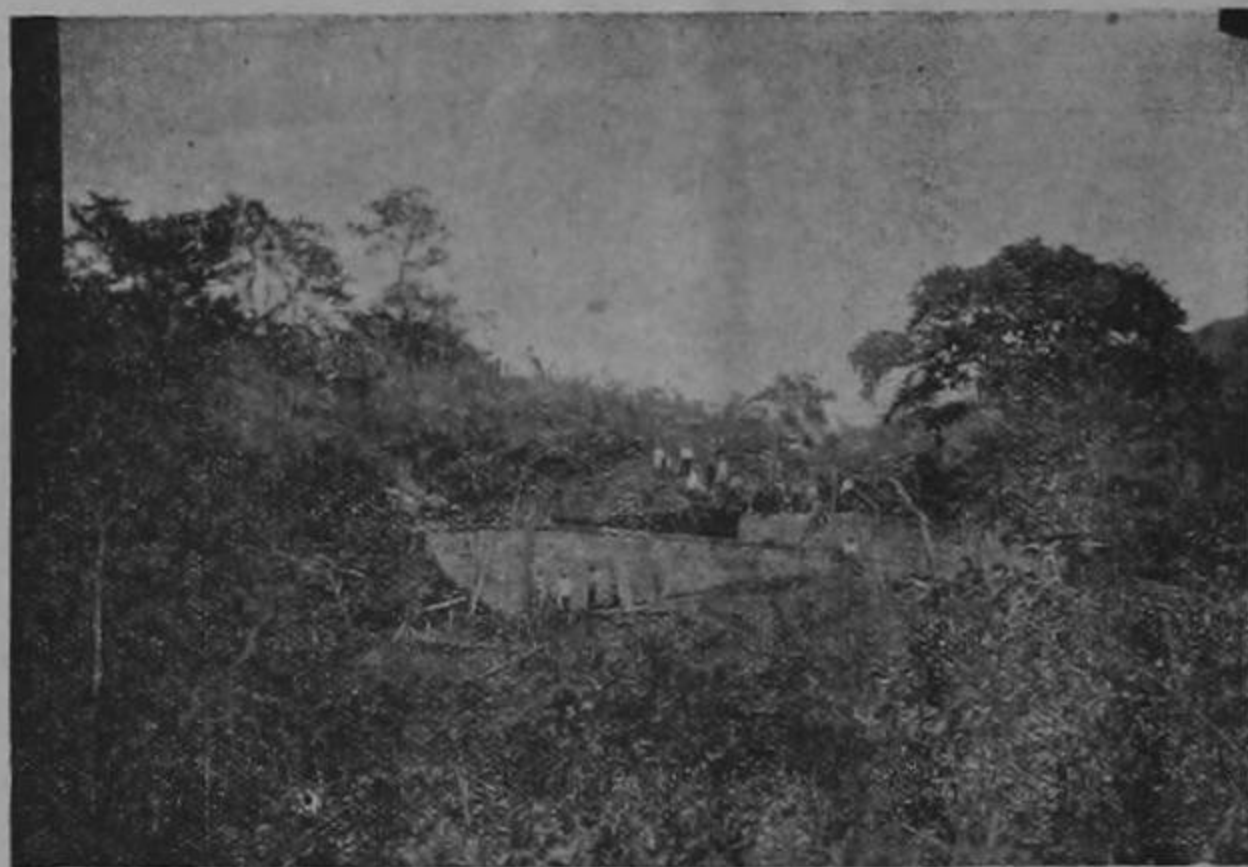
Vista lateral de los tanques de la Cañería de Puntarenas
