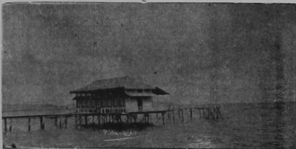
Baños Municipales de Puntarenas
