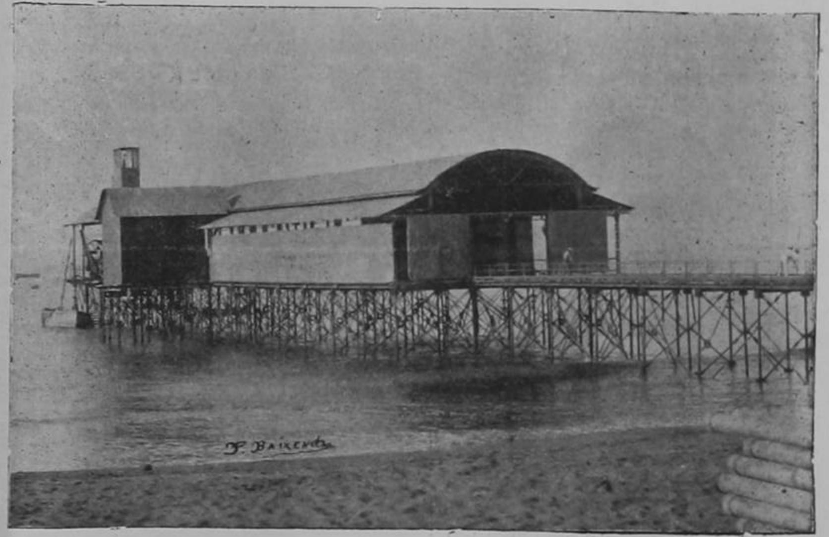
Muelle de hierro de Puntarenas
