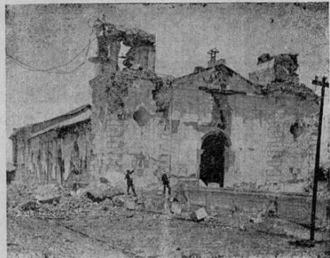
Estado en que quedó la iglesia de San Francisco por el terremoto de 1910. Las paredes laterales y las dos fachadas—adelante y atrás—eran de gruesa mampostería que hubo que demoler. El interior, construcción de madera, quedó en buen estado y es el mismo que hoy existe.
