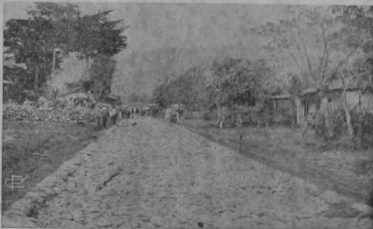
Cama de piedras para la formación de calzadas en el camino de San Rafael de Desamparados
