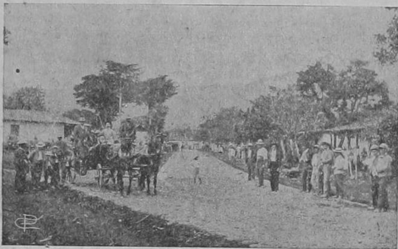
Camino vecinal arreglado por los vecinos de San Rafael de Desamparados, usando piedra redonda, ripio y piedra picada.
