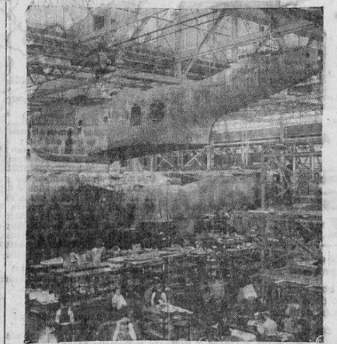
Ya está muy avanzada la construcción de este enorme avión bombardero de patrulla de 20 toneladas PMB-1, que se fabrica en la compañía de Glenn L. Martin, en Baltimore, Maryland
