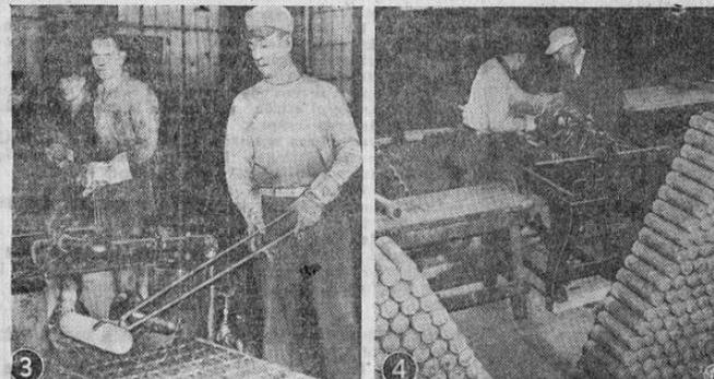
El paso siguiente es cuando el lingote después de haber sido calentado llega a la máquina forjadora. Después de perforado y estirado, quedó ya con la forma del casco de granada y se le coloca sobre arena para que se enfrie. A la derecha los cascos ya formados están listos para el torno que les hace la rosta y para la operación de cargarlos y colocarles la espoleta.
