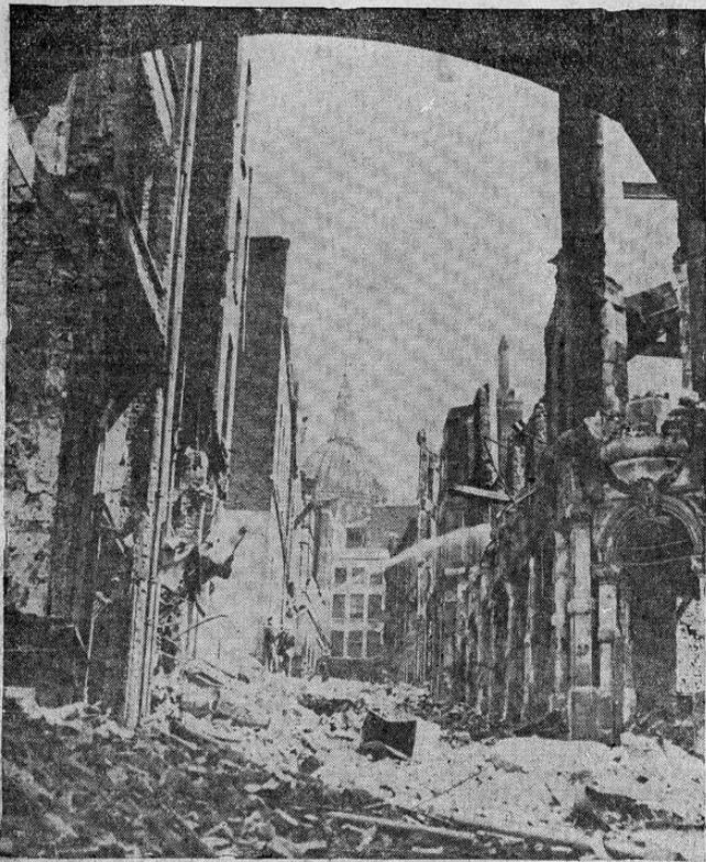
Los bomberos londinenses tratan de apagar los escombros de un edificio en la calle Pilgrim de Londres, inmediatamente después de un bombardeo de los aviones nazis. Al fondo de la foto puede verse la cúpula de la famosa catedral de San Pablo. — (Foto Acme Editors Press)
