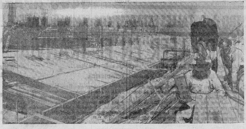
Una de las más grandes presas del mundo, actualmente en construcción en Estados Unidos
