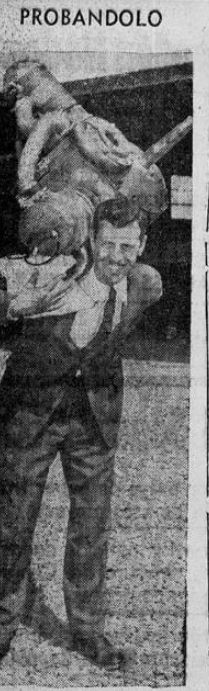
Al Bennet, piloto de pruebas y perito en aviación, carga sobre sus hombros el último tipo de motor de aviones norteamericano que pesa 167 libras y desarrolla 130 caballos de fuerza.—(Foto Acme-Editors Press).
