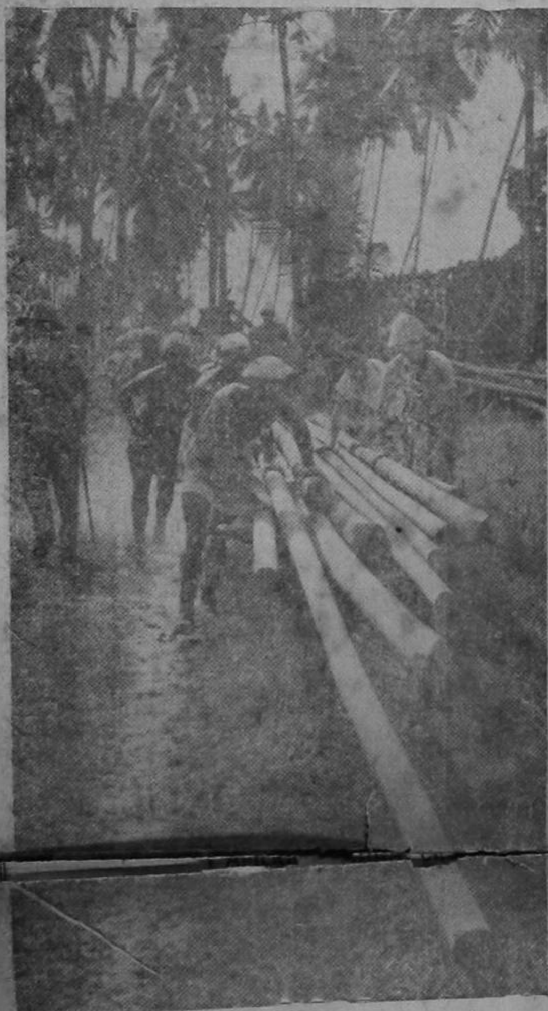
Soldados del ejército inglés en Malaya cooperando en la construcción de un puente en la península, donde tratan de detener el avance de las tropas niponas que intentan tomar Singapur. — (Foto Acme-Editors Press).
