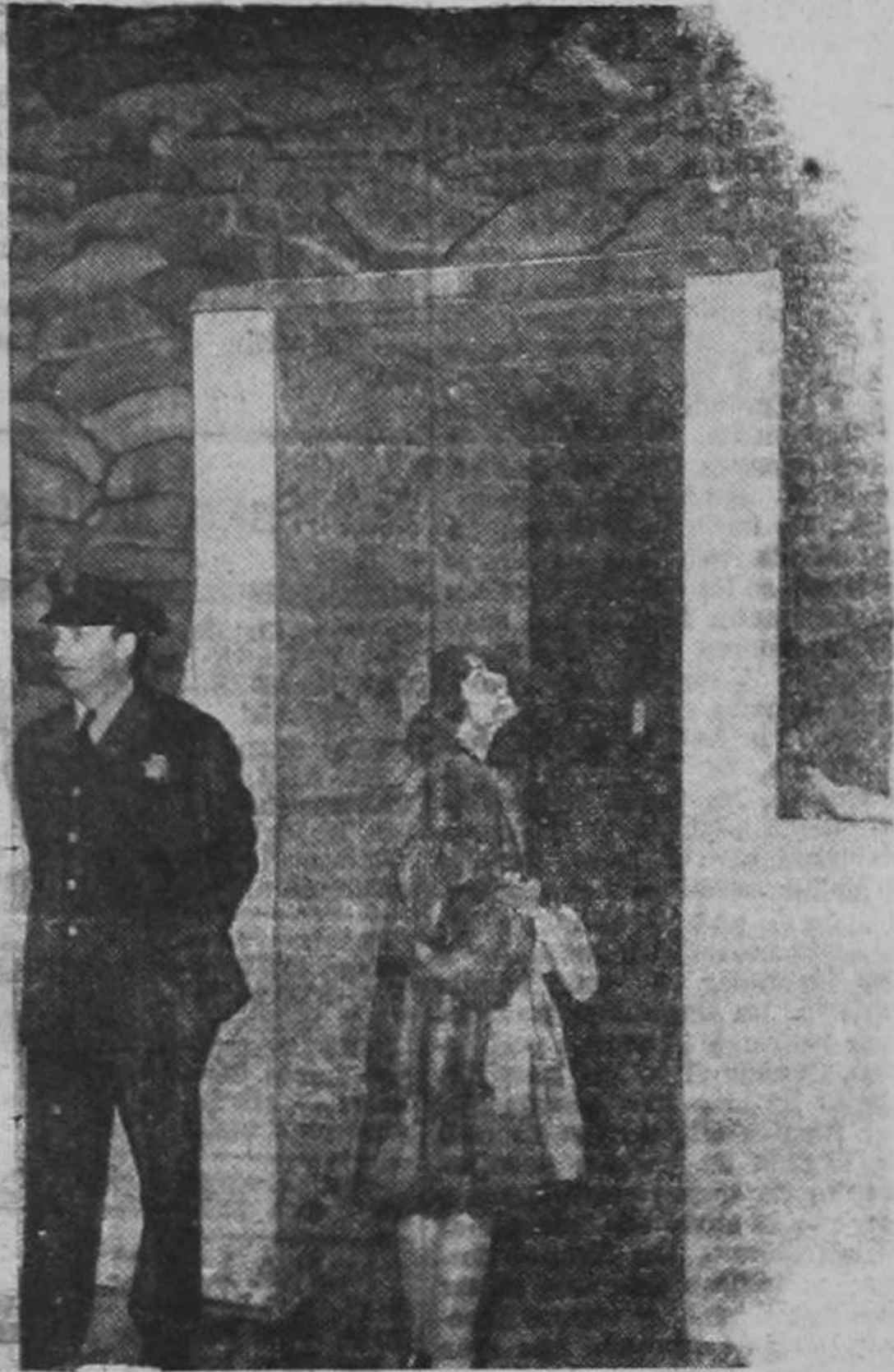
El edificio de la International Telegraph and Telephone en San Francisco ha tomado desde el primer momento las precauciones necesarias contra los ataques aéreos enemigos. La foto muestra la entrada del edificio citado.
