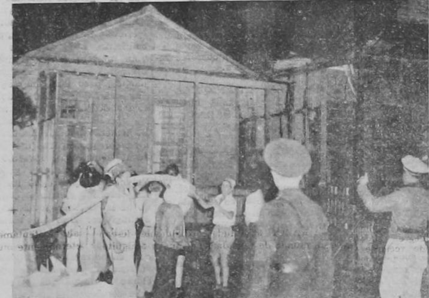
Aspecto del tremendo incendio de anoche. Momentos en que se trataba de contener el fuego en la residencia de la familia Montero.
