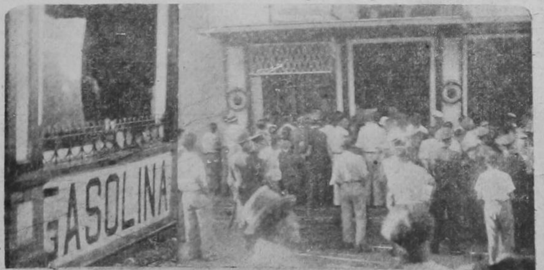
He aquí una composición fotográfica de los instantes que sucedieron al principio de incendio esta mañana a las siete en la bomba de gasolina de Borbón. Puede apreciarse la ausencia de los vidrios de las ventanas que fueron quebrados y grupos de curiosos y pelotón de policiales
