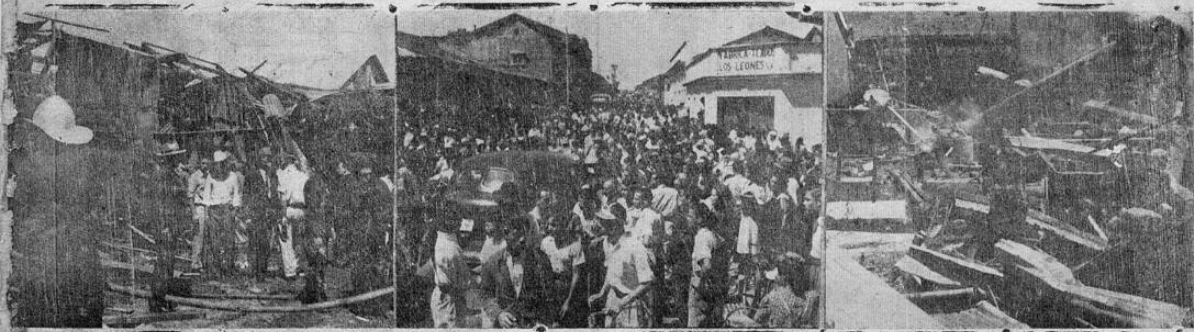
Diversos aspectos de la espantosa catástrofe ocurrida hoy en el telar Los Leones, al estallar una caldera.
