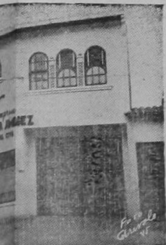
EDIFICIO DE LA EMPRESA OFICINAS EN LA AVENIDA CENTRAL
