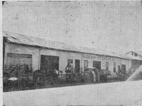
250 VARAS AL NORTE DE LA ESTACION DEL FERROCARRIL ELECTRICO AL PACIFICO, CALLE 2 AVENIDAS 14 Y 16.
