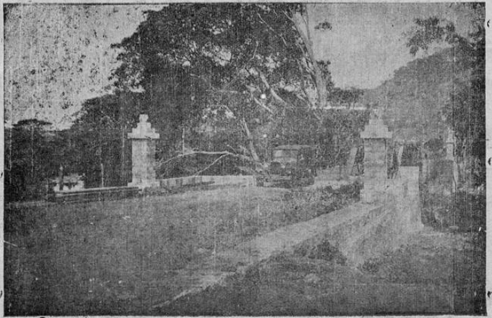
Puente de Matagalpa en la carretera de esa ciudad a Nicaragua
