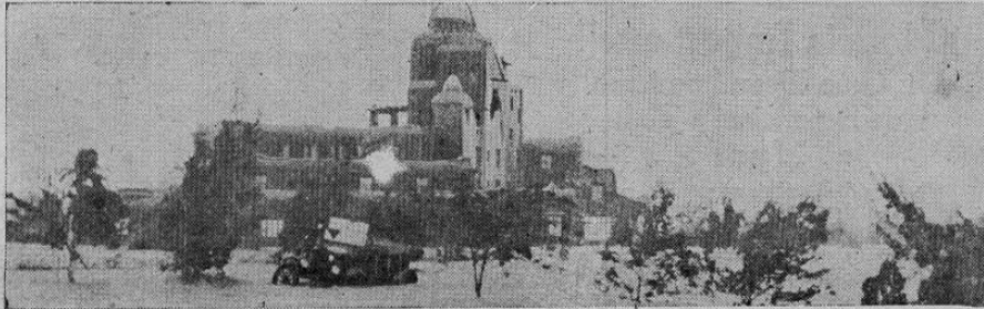
A causa de las fuertes lluvias, las regiones bajas de Florida, especial mente cerca de Miami, han sufrido continuas inundaciones. Millones de acres han quedado cubiertos por el agua. La foto mues tra un aspecto de los suburbios de Miami.
