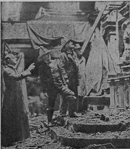
Un incendio causó daños que pasan de cien mil dólares en la iglesia de San Esteban, en Boston. Aquí aparece su párroco, el Reverendo Charles White, examinando con los bomberos las ruinas del altar
