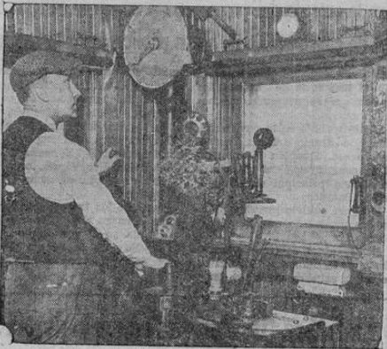
Eduardo Lundahl muestra aquí todos los aparatos necesarios para el control de un puente de Chicago, cuya estructura se abre para dejar paso a las embarcaciones
