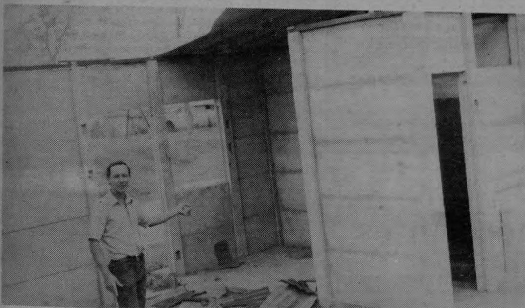
Los "módulos" habitacionales se componen de tres paredes y dos láminas de ricalit. Así pretende el gobierno cumplir con sus metas de vivienda
