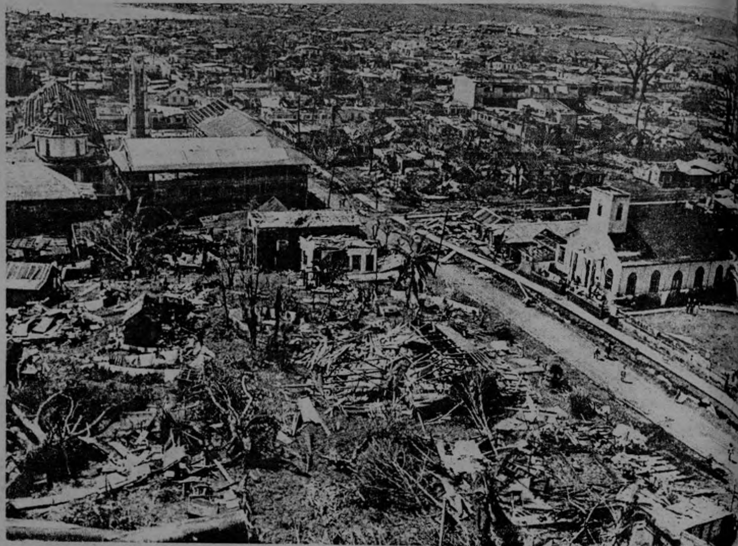
Aspecto parcial de la ciudad de Bluefield muestra la destrucción causada por el paso del huracán "Joan".
