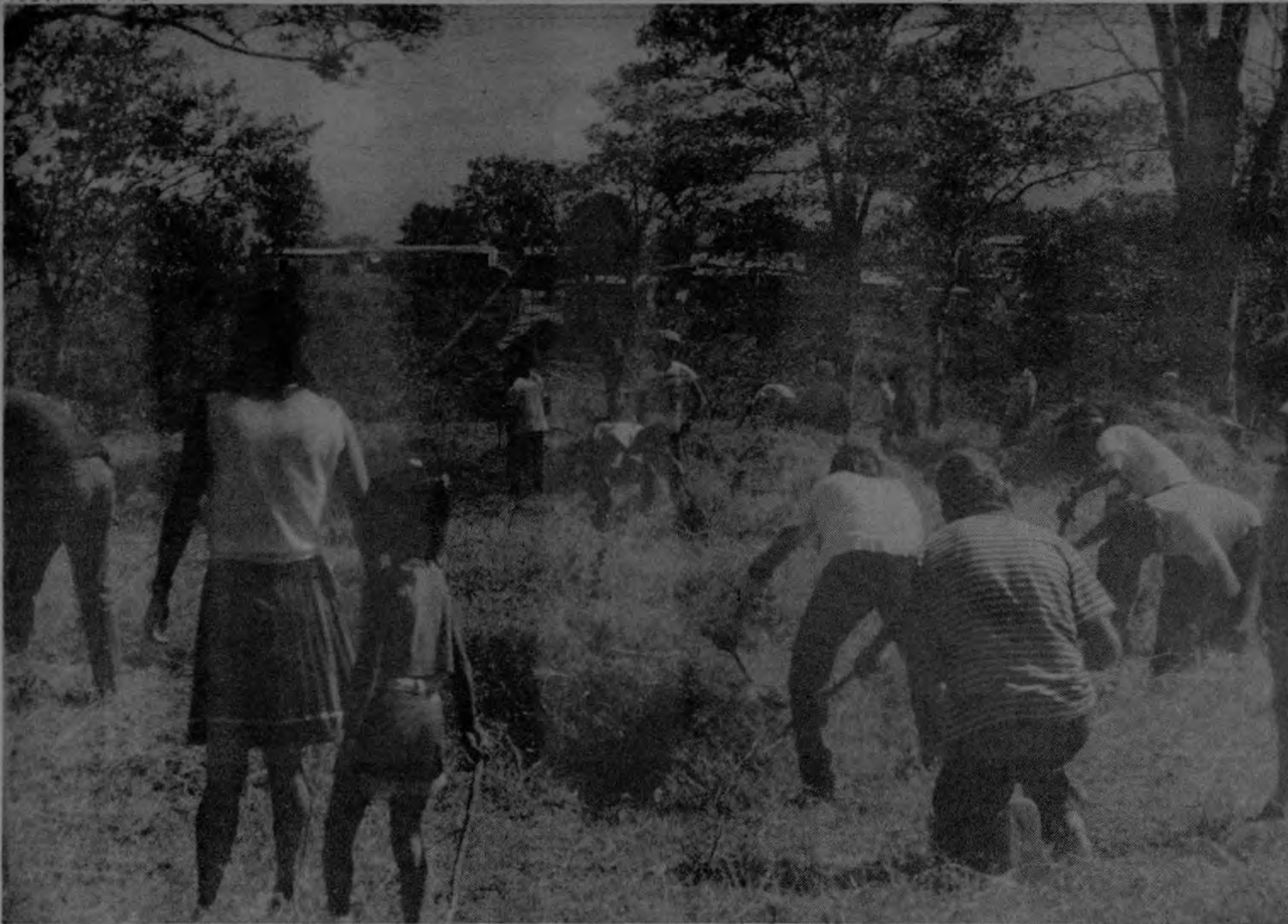
Con energía y entusiasmo, las familias limpian los terrenos donde pronto comenzará la construcción de sus viviendas.
