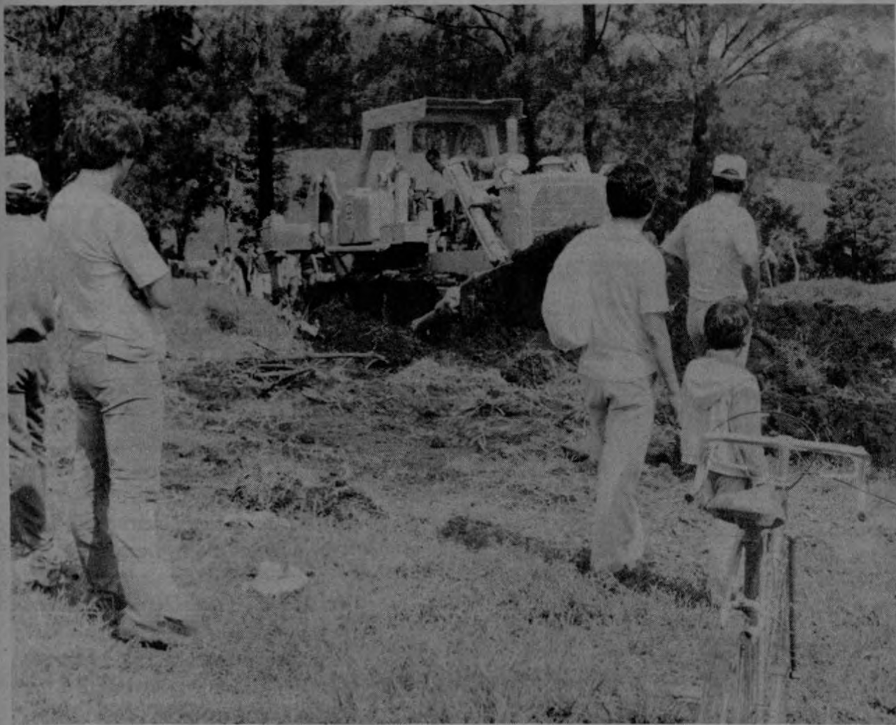
Los tractores han empezado a remover la tierra donde se construirá la Ciudadela Joaquín García Monge, en los alrededores de San Felipe de Alajuelita.
