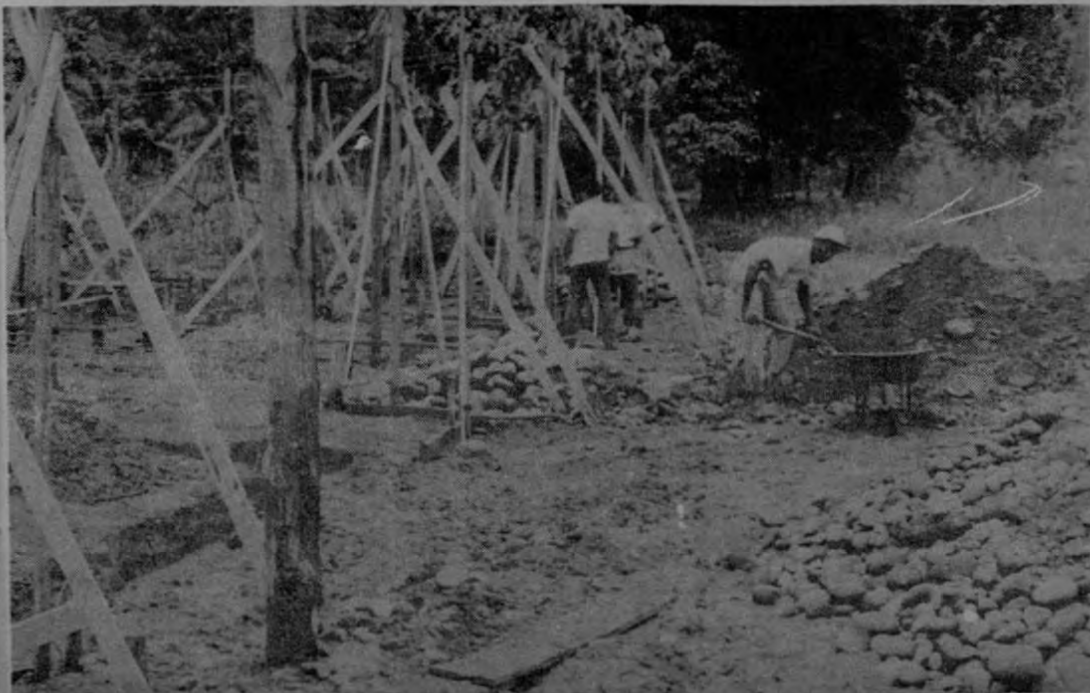
Siquirres: las primeras piedras se han puesto, ahora ya nadie puede detener el avance de las construcciones.
