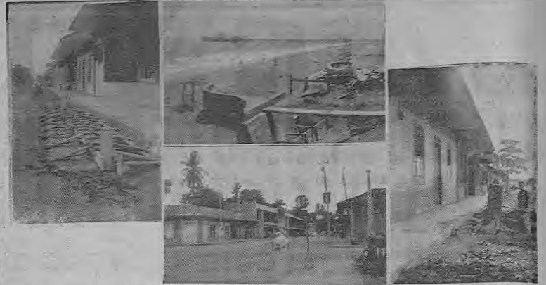
Meses, nuestro corresponsal viajero, nos trajo de Puntarenas este arreglo gráfico, que explicamos así: arriba, izquierda: cordón y centro: un aspecto de los trabajos que se realizan en la construcción de la Carretera Panorámica, que va desde el muelle hasta Barranca, como se están nivelando y arreglando las vías principales del puerto; abajo, centro: la foto muestra cómo se están nivelando y arreglando las vías principales del puerto; abajo, derecha: un aspecto del trabajo que se está haciendo en el tránsito y constituyen un grave peligro. Es satisfactorio decir que Puntarenas marcha a ritmo de progreso, y que los vecinos colos boran con estas obras de beneficio colectivo con mucho entusiasmo.
