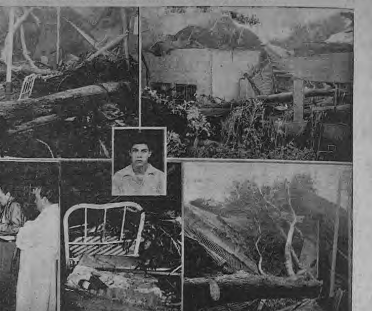
Las fotografías superiores dan idea de los grandes destrozos ocasionados por la caída de los árboles sobre el Pabellón Nor-oeste del Sanatorio. Lo que fue un dormitorio es ahora un cúmulo de escombros, donde los hierros retorcidos de los cates, se confundieron con las vigas de los techos, cercas quebradas, pilares de cemento desmenuados y troncos. Al centro, la última fotografía de Francisco Valverde Hidalgo, quien pereció instantáneamente por trituramiento. — A la izquierda, Efraín Delgado Galdá, quien se salvó milagrosamente, en un salón de ablamiento con nuestro redactor Sotela. Centro inferior, el sangrante y desmenuado cadáver de un niño que ocupaba Valverde Hidalgo. Las últimas fotografías es una vista tomada de un plano más alto. Se aprecia claramente el alcance de las largas ramas sobre los techos. (FOTOS AREVALO).
