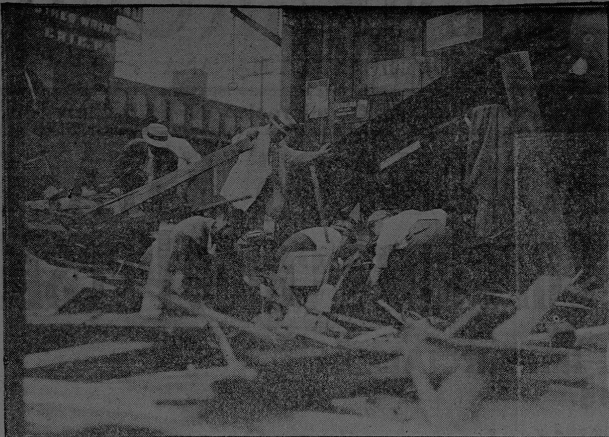
Ruinas de una casa azotada por el huracán
