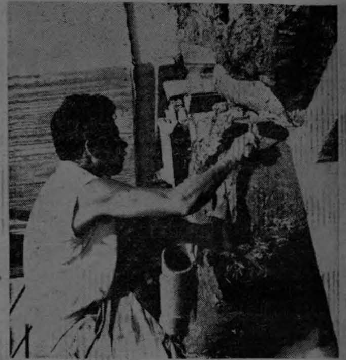
El albañil don Ricardo Navarro, del Departamento de Construcción, Ingeniería de Coto, coloca uno de los sifones de drenaje de aguas en las casas de nuevo tipo que se construyen en las fincas nuevas que se abren en el Valle de Coto. Junto con sus compañeros, coopera en el avance de los trabajos.
