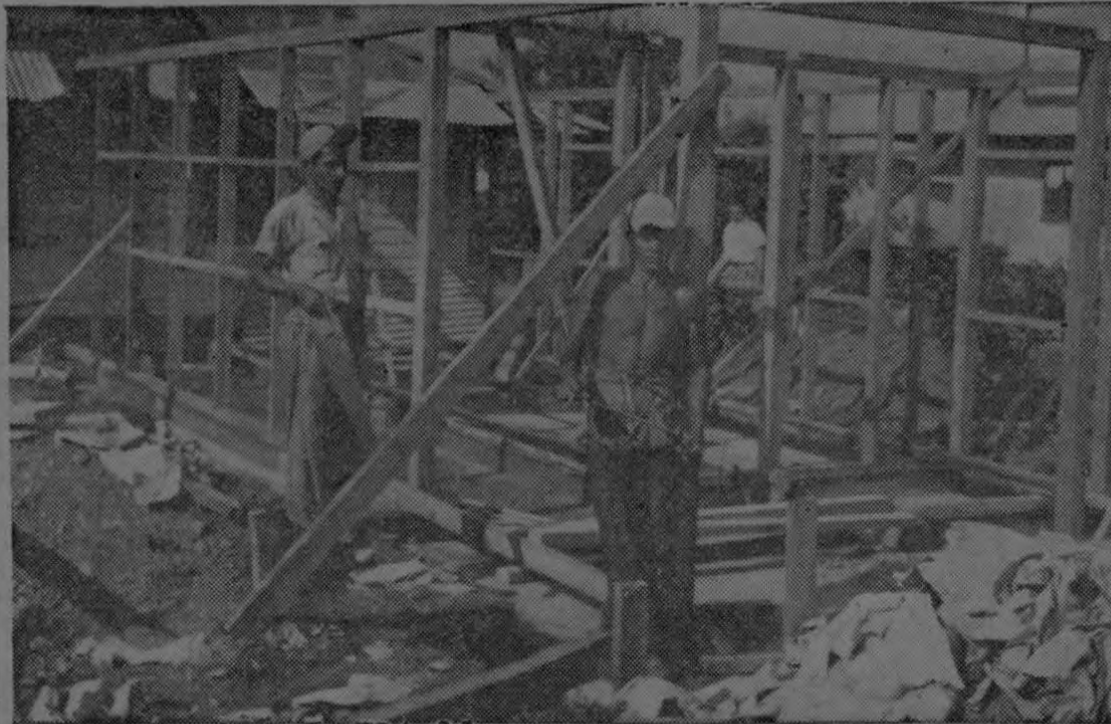
La gráfica de Zavaleta muestra un aspecto parcial de los trabajos de construcción del anexo de la Jefatura Política de Golfito, en donde se instalará la nueva Unidad Sanitaria de la población civil. Los trabajadores Hermógenes Gómez A. y Rubén Mayorga, se ven en la foto disponiéndose a la tarea.
