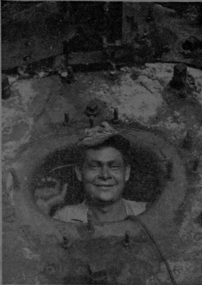
Eduardo Quirós, a quien le ha sido confiada la jefatura de Caldereteros del Mecánico de Golfito, durante las vacaciones del Jefe don José Antonio Cruz. Quirós aparece aquí asomando su rostro por la portezuela de la caja de fuego de la locomotora Nº 92, en reparación general en dicho taller.—(Foto de Salas)
