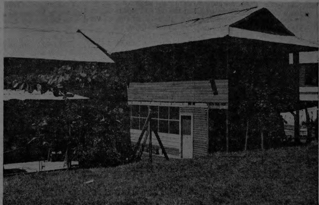
La Unidad Sanitaria de Golfito ha sido ampliada en su planta baja y un segundo piso ha sido agregado a la misma. Nuevas salas para una mejor y más cómoda consulta forman la modificación. En el alto estará ubicada la casa de habitación del médico permanente, quien podrá estar siempre a mano para
