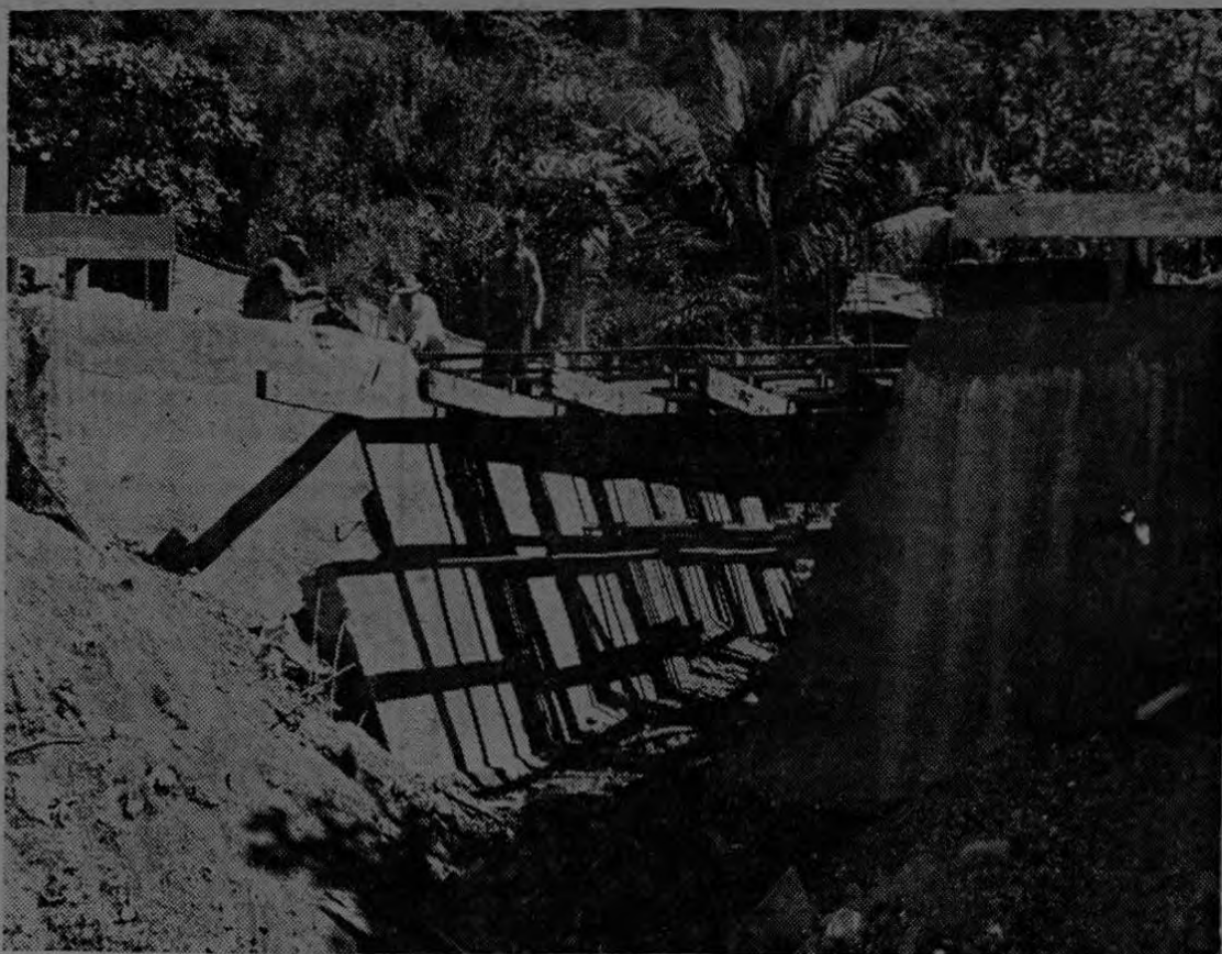
En su afán de mejorar el estado de las calles de Golfito, en su sección de lo que se conoce como "Población Civil", la Municipalidad del cantón ha comenzado la construcción de este sólido y moderno puente a la entrada de la misma. La obra, como pueden ver nuestros lectores, está muy avanzada y los trabajos se terminarán dentro de muy pocas semanas.
